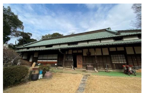
▲池谷家住宅主屋(改修前)
